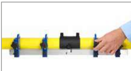
8. Utilizar um posicionador para fixar o tubo.
