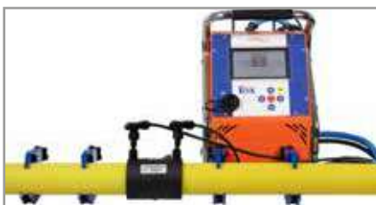
11. Início da soldadura.
