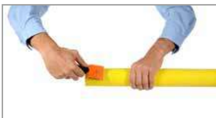
5. Raspar a zona de soldadura do tubo.
