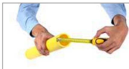
1. Medir o diâmetro do tubo.
