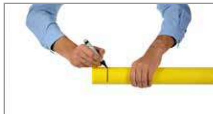
7. Marcar a profundidade de inserção do tubo.
