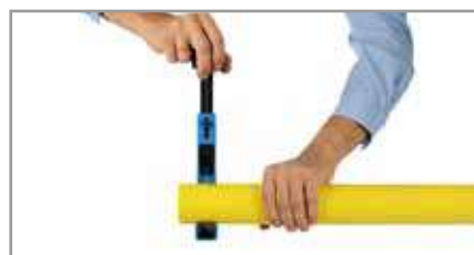
3. Cortar o tubo de forma totalmente reta.
